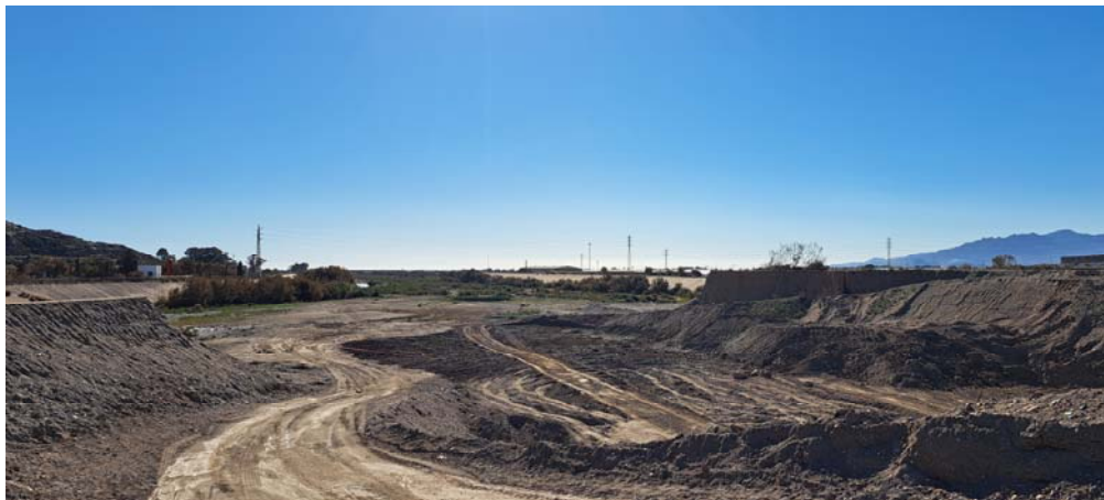
Camino junto a rambla Canalejas y conexión con camino junto a río – en obras
