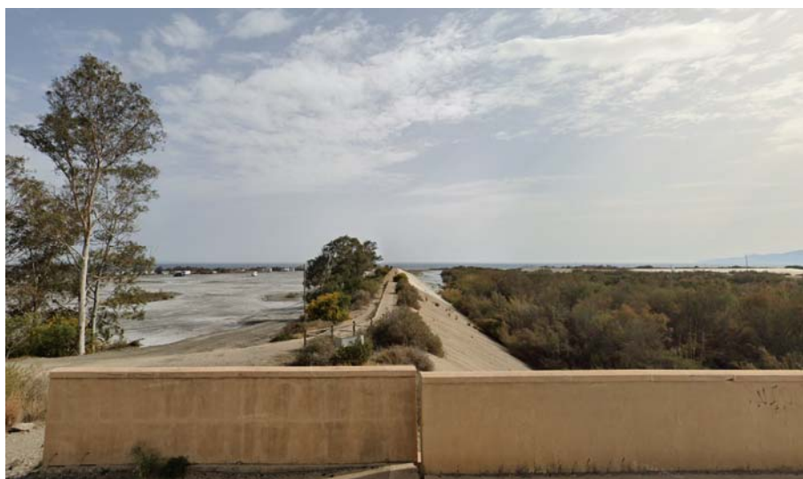
Tramo de la desembocadura desde carretera
