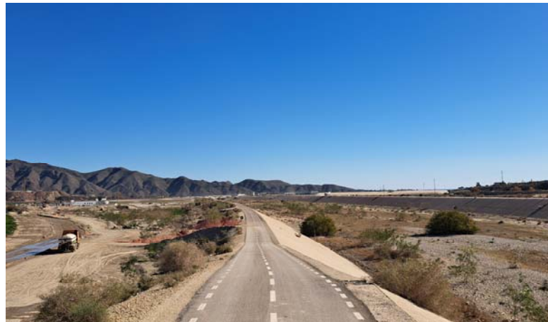
Punto kilométrico 10.5 aprox. Con obras hidráulicas
